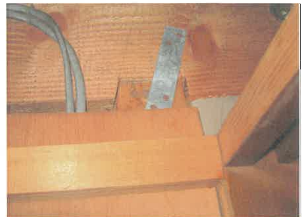
36 部位:1階天井裏 筋違上部 金物止め
