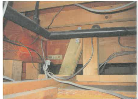
34 部位:1階天井裏 筋違上部 金物止め
