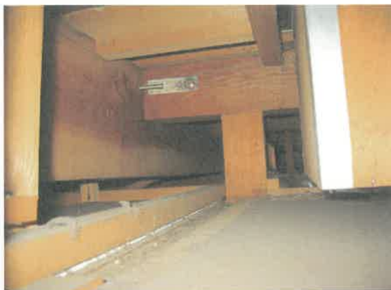
35 部位:1階天井裏 羽子板金物
