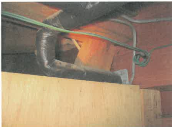
33 部位:1階天井裏 筋違上部
